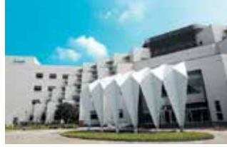
Tainan Fabrika (Elmas Sınıfı Yeşil Bina)
